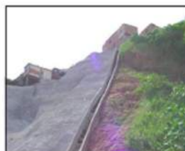
Cicatrizes de escorregamento. Observar moradias muito próximas ao talude podendo ser atingidas por futuros eventos de escorregamentos Favela Galinha D'água
