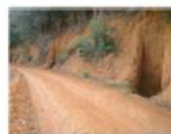
Caixa seca implantada em estrada vicinal no município de São Roque do Canaã-ES.
