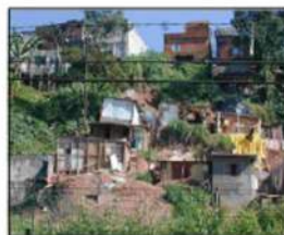
Cicatrizes de escorregamento e evidências de instabilidades das moradias na orla da talude Favela Paratópolis
