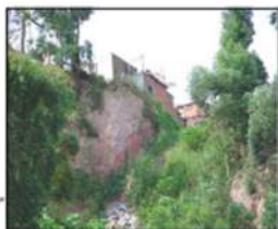
Vista do escorregamento destruindo parte das moradias na base do talude Favela Paratópolis
