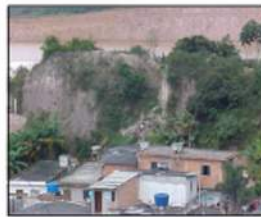
Notar a elevada inclinação do talude da antiga ova da mineração de areia, além das falções erosivas e a posição das edificações na orla e base do setor Jardim Varginha
