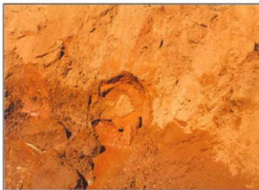
Minas d'água no talude
