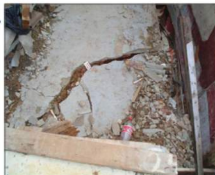
Trincas no terreno
