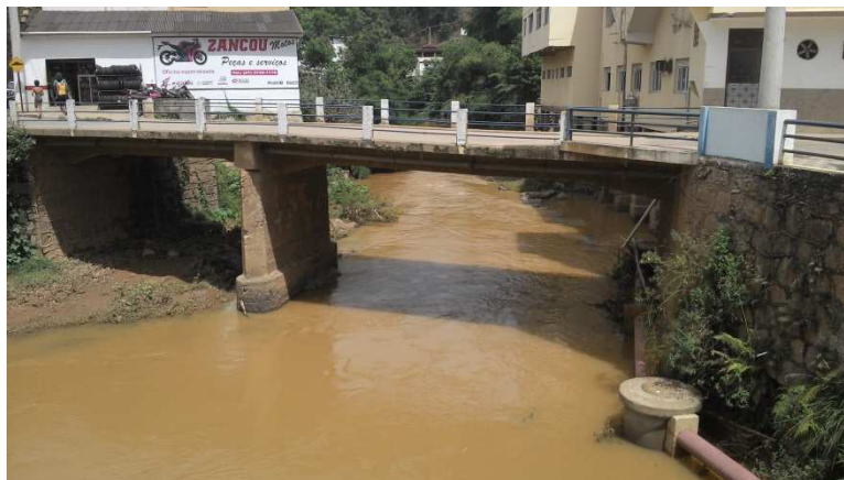
Figura 4-11: Seção hidráulica da OAE da Rua Marechal Deodoro sobre o Rio Guandu.
