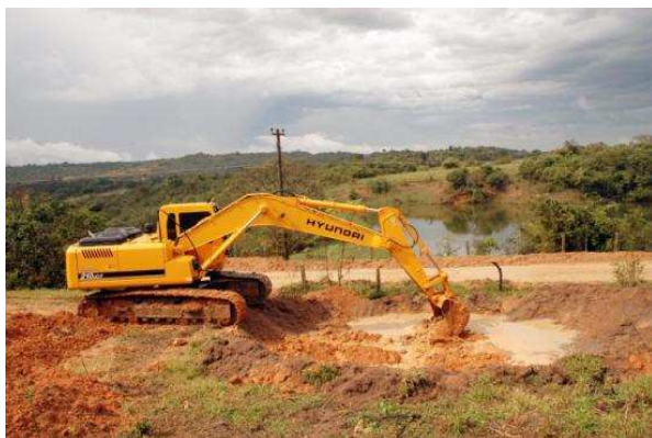
Figura 7-4: Implantação de uma bacia de retenção às margens de uma estrada vicinal
