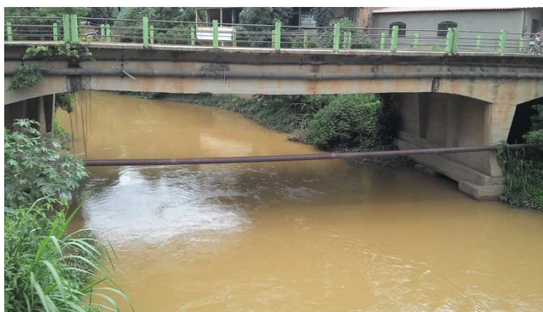
Figura 4-10: Seção hidráulica da OAE da Rua Otílio Ronceti sobre o Rio Guandu.
