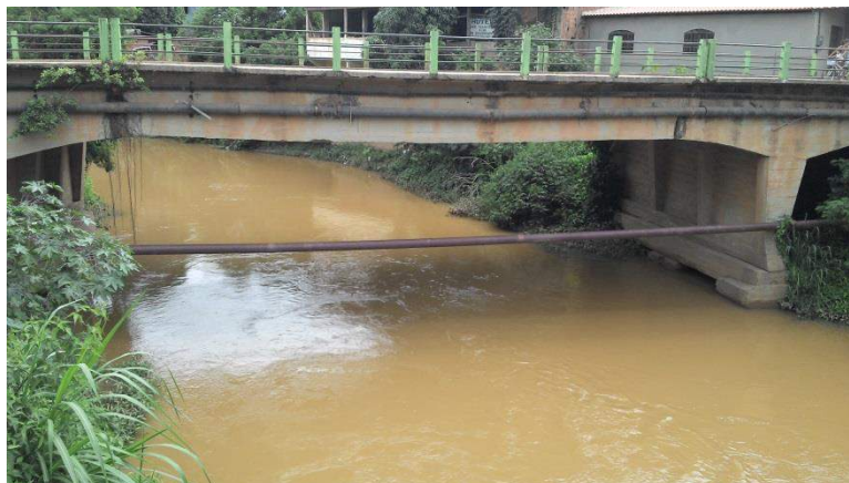
Figura 6-14: Seção hidráulica da OAE da Rua Otílio Ronceti sobre o Rio Guandu.
