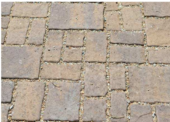
Figura 7-11: Pavimento poroso.
