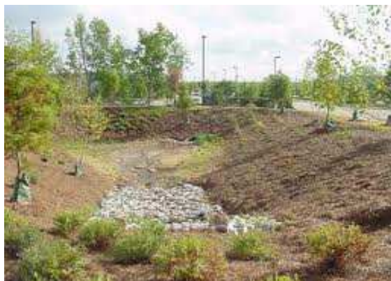
Figura 7-15: Bacia de detenção.
