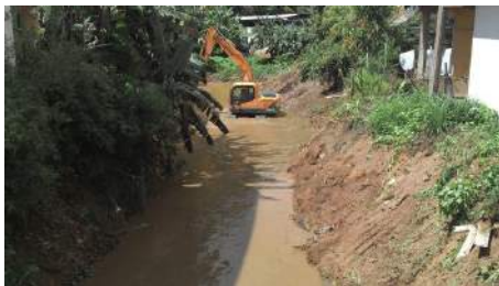
Figura 6-12: Retroescavadeira executando dragagem do Rio Pardo, em 09 de dezembro de 2013.
