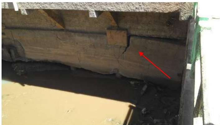
Figura 6-17: Muro de concreto para proteção da fundação da edificação localizada na ponte da Rua Michel Chequer. Detalhe para a rachadura causada pela força da água.
