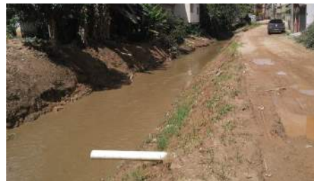
Figura 6-13: Dragagem executada próximo à via de acesso a Ibatiba, no Rio Pardo.
