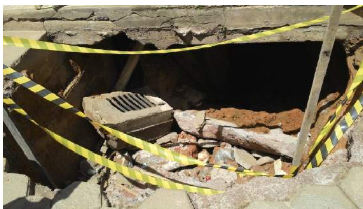
Figura 6-18: Efeito do escoamento d'água através do muro de proteção defeituoso.
