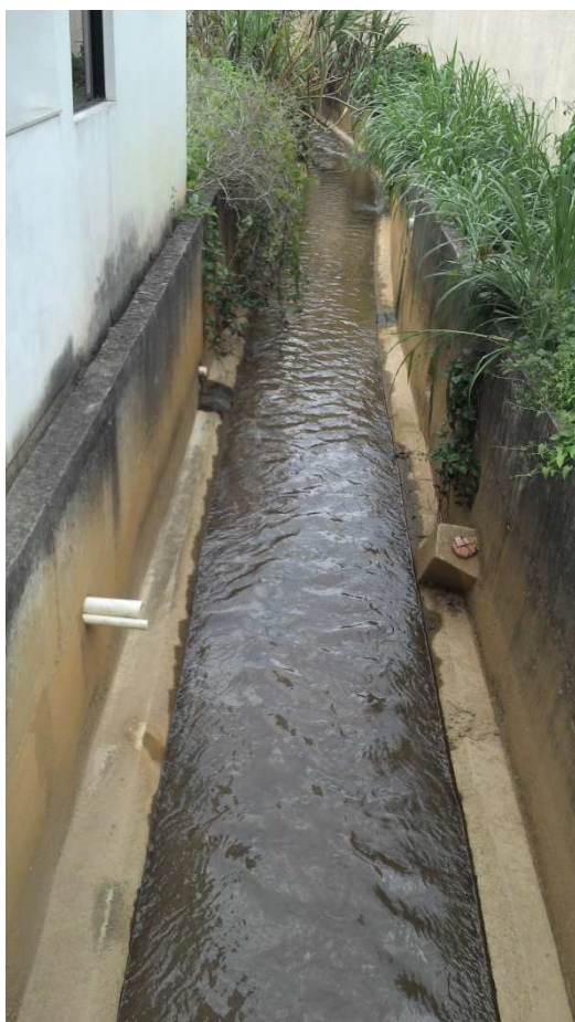
Figura 6-9: Canal de concreto do córrego Batatal
