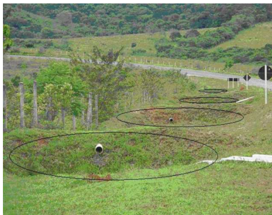
Figura 7-3: Bacias de retenção instaladas às margens de rodovia pavimentada.
