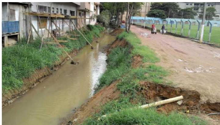
Figura 6-15: Estrutura de madeira temporária instalada no Rio São Luiz.
