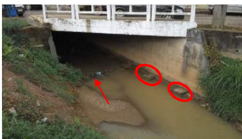
Figura 6-12: OAE na Rua Floriano Berger. Detalhe para as bases de concreto e para o acúmulo de resíduos.
