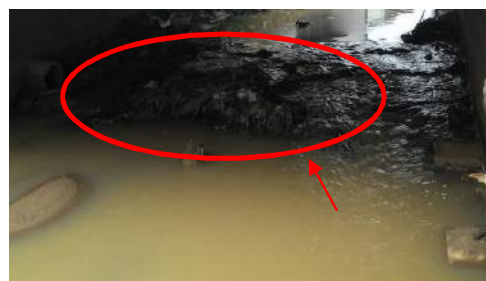
Figura 6-13: OAE na Rua do Imigrante. Detalhe para o acúmulo de resíduos.
