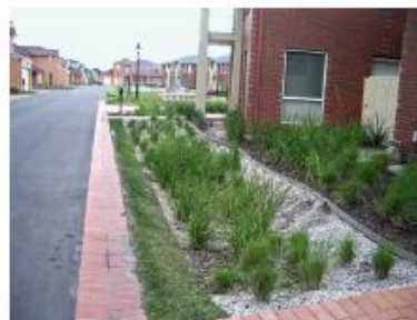
Figura 41 – Esquema e exemplo trincheiras de infiltração e de retenção.
