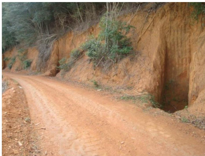
Figura 11-5 – Exemplo de caixa seca implantada em estrada vicinal.
