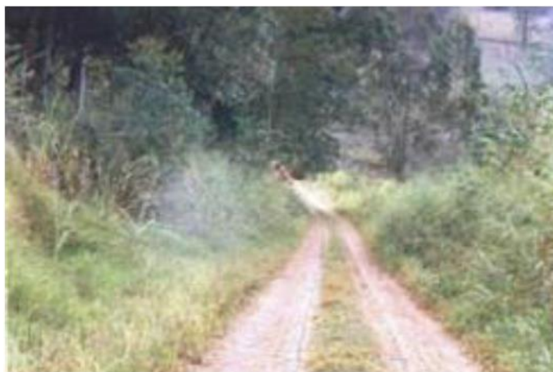
Figura 11-6 – Taludes de corte e aterro e áreas não transitáveis recoberto com espécies herbáceas em estrada vicinal.
